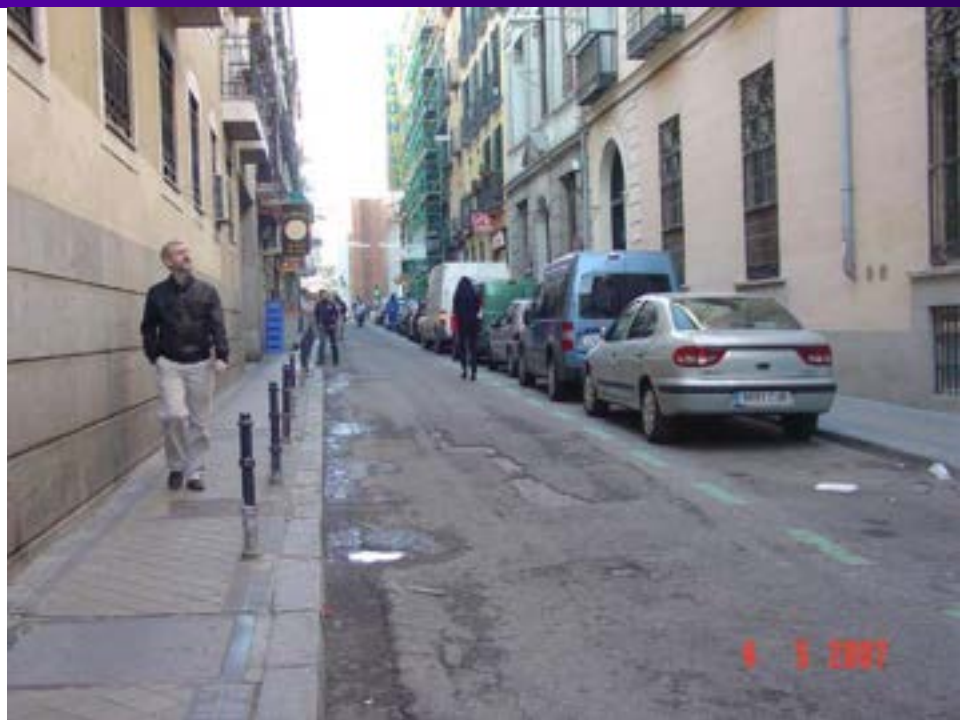
Las Áreas de Rehabilitación Integral ARIS
