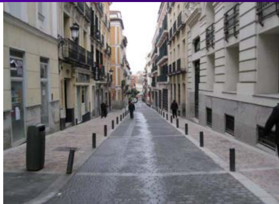
Las Áreas de Rehabilitación Integral ARIS
